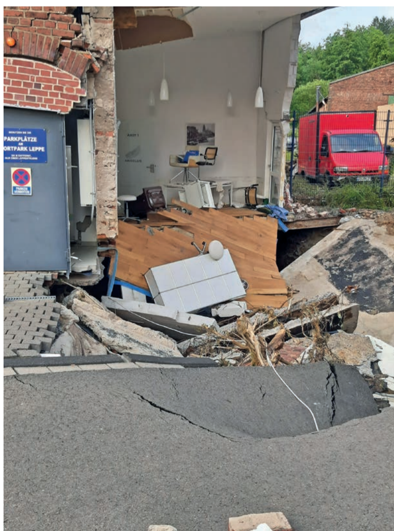
Zerstörte Praxis in Engelskirchen an der Leppe
